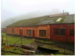
新線の第5機械棟の横を進みます。
