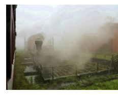
ボイラー棟のそばの大きな穴のような施設。
