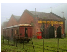
車内から見た新線用第5機械棟。
