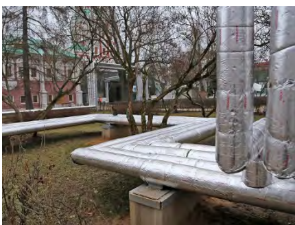
いかにも工事中という気合の入った配管！
